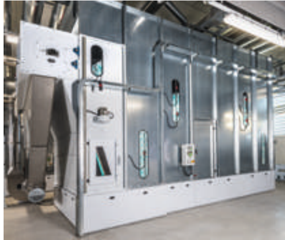
Mischkammer mit komponentenunabhängigem Mischsystem
