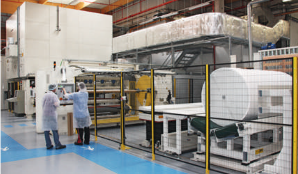
Vollständige von Trützschler Nonwovens gelieferte Anlage
